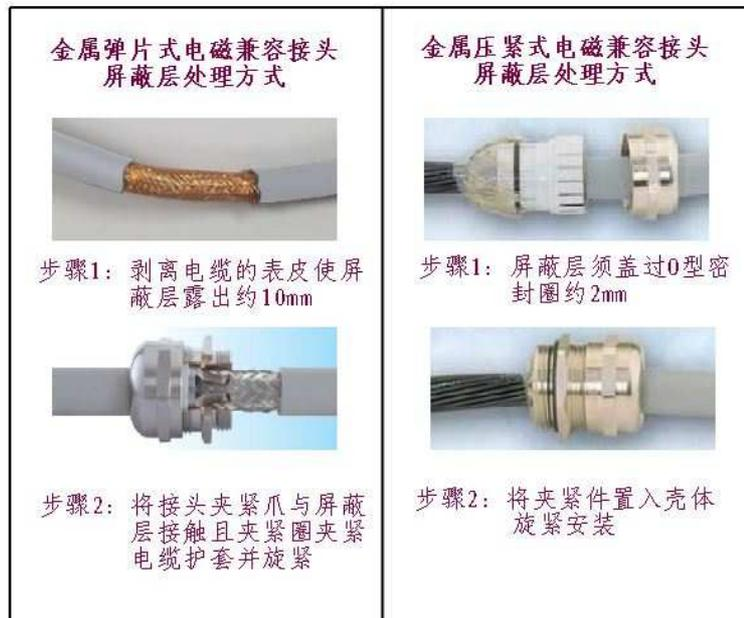
图 6-3 电磁接头屏蔽层处理方式
